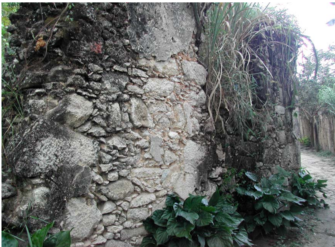
FIGURA 6 – Muro de arrimo adjacente à casa grande.
